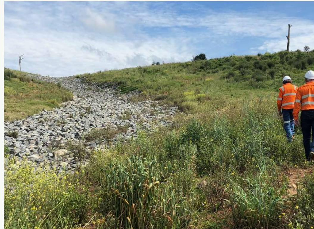
➤ Figura VII. Imagen superior, detalle de un ejemplo de restauración geomorfológica «híbrida» (método australiano), con un fondo de cauce armado con rocas. Imagen inferior, proceso de restauración minera progresiva de base geomorfológica: un camión minero está descargando estériles en la parte superior de la escombrera, adaptada al diseño geomorfológico, mientras que a su pie toda la base de la escombrera ya está restaurada. Imágenes tomadas en minas de carbón de Hunter Valley (Nueva Gales del Sur, Australia). Autor: J.F. Martín.
