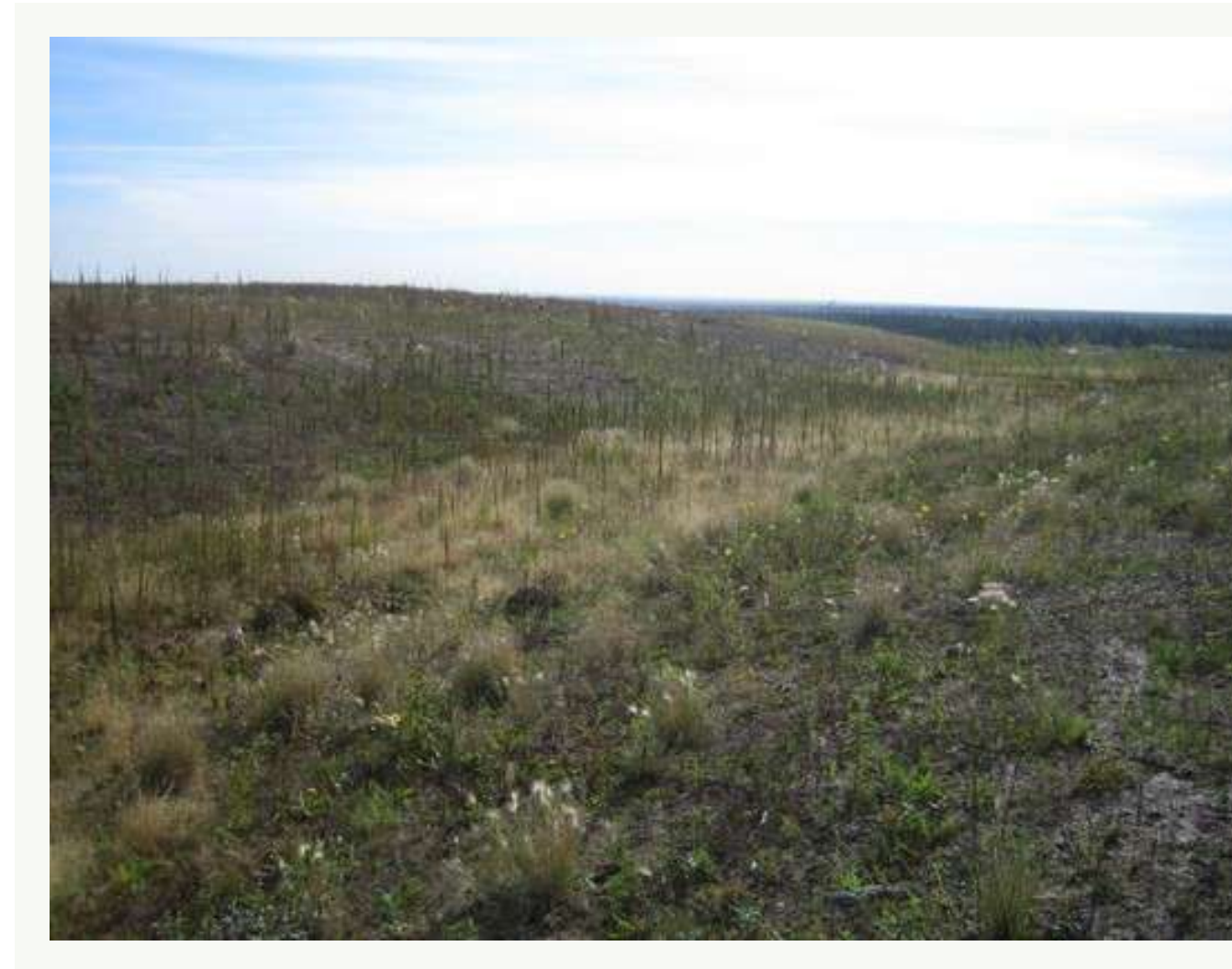
➤ Figura II. Cauce efímero, colonizado por vegetación ( vegetated waterway ), construido sobre escombreras mineras de Canadá occidental.
