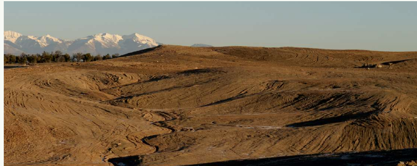
➤ Figura IV. Restauración mediante GeoFluv en la mina La Plata, Nuevo México (Estados Unidos), donde nació el método. Imagen superior, reconstrucción de una gran escombrera minera, con anterioridad al proceso de revegetación. Imagen inferior, otro sector de la escombrera tras dos años desde su semillado, mostrando ya una comunidad vegetal diversa. Ambas imágenes muestran paisajes organizados sobre la estructura que tienen las cuencas hidrográficas naturales, con cauces principales zigzagueantes y meandriiformes, de los que parten una serie de lomas y vaguadas alternas, que configuran laderas festoneadas, de perfiles longitudinales convexo-cóncavos. Esa estructura es idéntica a la de la mayoría de los paisajes de la superficie terrestre (véase la similitud de estos paisajes construidos con los naturales de la figura III ). Autor: E.E. Epp.
