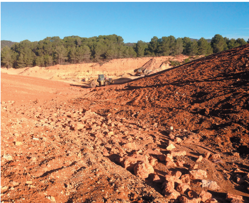
Figura 4. Canal fluvial principal que drena el sector 1 (ver Figura 2) del sector restaurado entre finales del año 2019 y enero de 2020 (ver Figura 3). Nótese la incorporación de un armado, que reproduce la rugosidad de los lechos de las ramblas del entorno.
