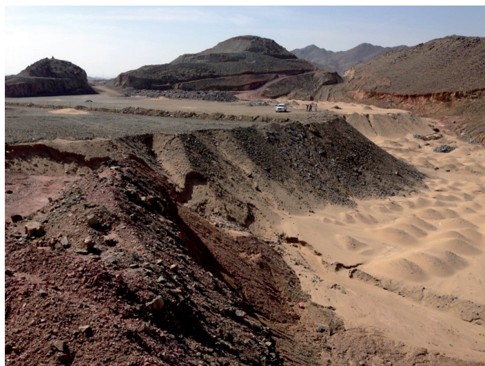
Figura 1. Vertedero en la obra del tren de Alta Velocidad entre Medina y La Meca, Arabia Saudí, rellenando una depresión natural. Año 2014
